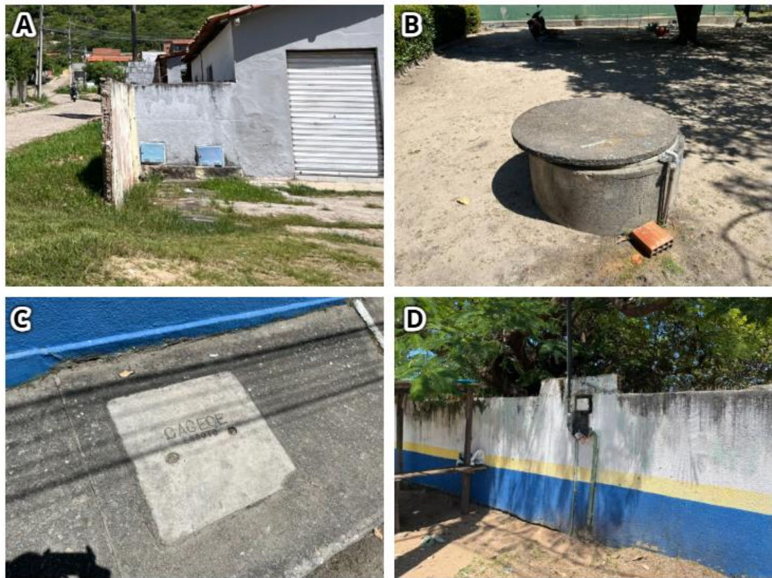
Figura 25: Infraestrutura existente: A - Registro de água em residência próxima ao terreno do CEI 4; B – Poço localizado dentro da área do CEI Nossa Senhora das Graças; C – Identificação de infraestrutura para rede de esgoto (CAGECE); D - Identificação de estrutura para energia elétrica; E – Acesso pela Rua Ivo Paixão com a presença de drenagem no lado direito da rua. F – Drenagem presente na linha férrea próxima ao equipamento; H – Linha Férrea próxima ao terreno.
