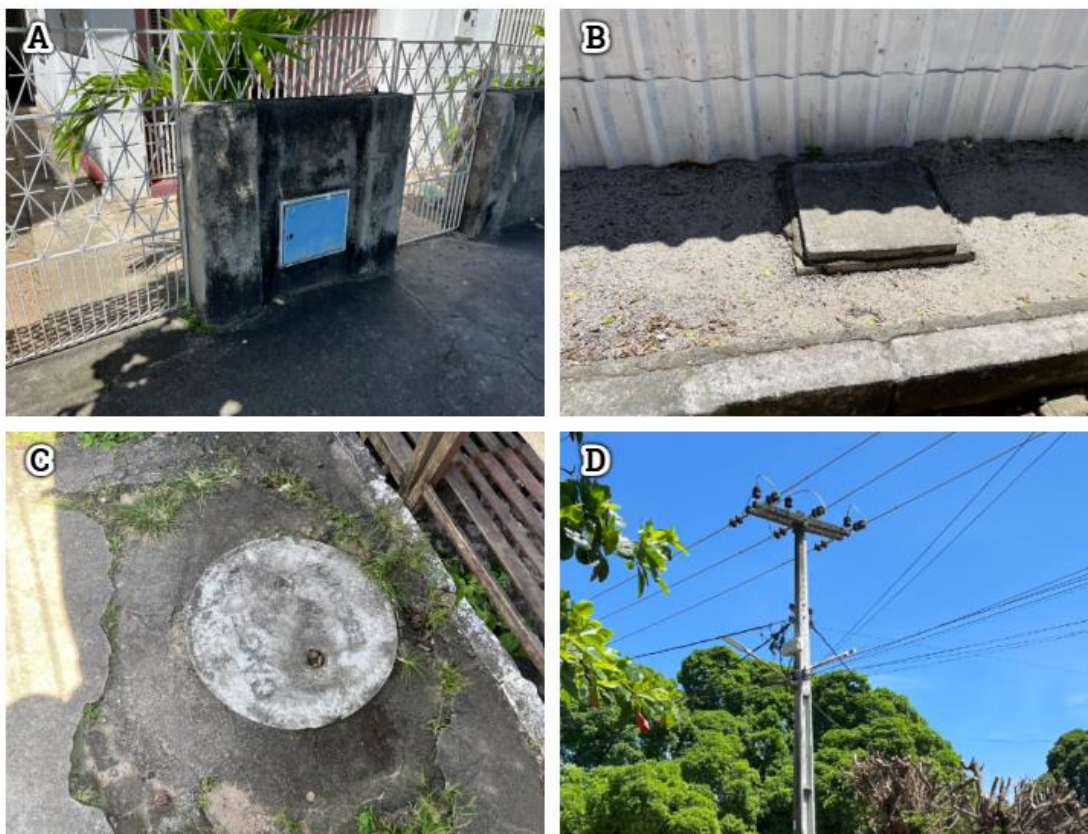
Figura 24: A - Registro de água em residência próxima ao terreno do CSMI; B - Infraestrutura de esgoto na área interna do imóvel; C - Identificação de infraestrutura para rede de esgoto (CAGECE); D - Identificação de estrutura para energia elétrica; E e F - Infraestruturas de Drenagem próxima ao equipamento; G - Área do imóvel totalmente cercada e fechada; H - Área interna do imóvel já parcialmente cimentada e com a presença dos contêineres.
