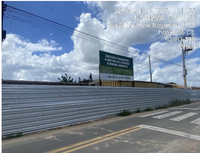
Obras da Unidade Básica de Saúde (UBS), situada aos fundos do terreno do CRAS. Fonte: Vistoria no local.
